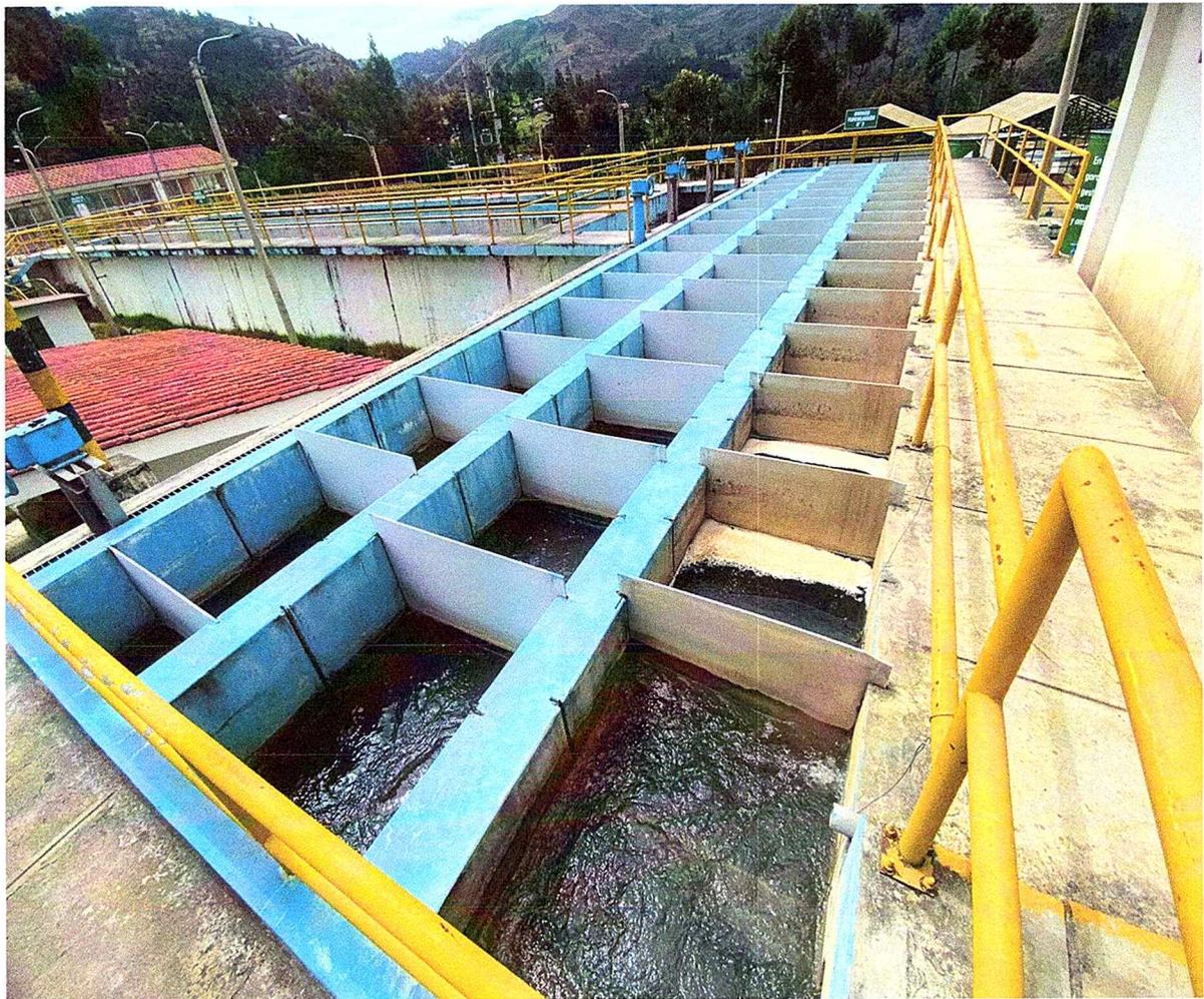
Imag. 1.15 Imag. 1.14 Unidad de floculación modulo N° 02
