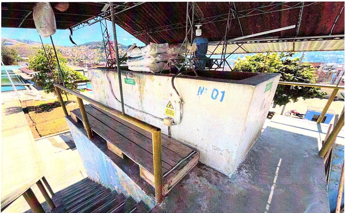
*Imagen 6: Tanque de Preparación de sulfato – PTAP “Santa Apolonia”*
