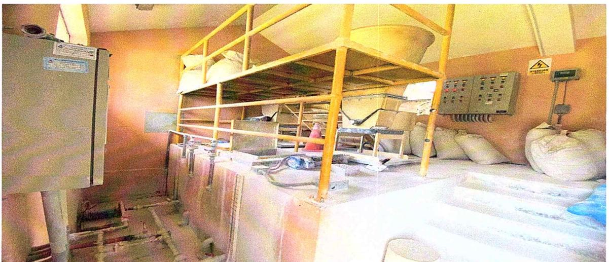
Imag. 1.7 Tanques de preparacion de Cal Hidratada
